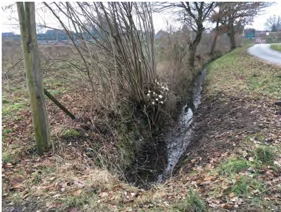
Abbildung 2-2: Foto (19.02.2018) Graben, östlich des Ossenpadds. Blickrichtung von Norden nach Süden. Im Hintergrund Baustelle Westumgehung.
