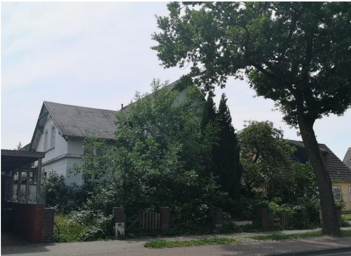
Abbildung 2: Leerstehendes Gebäude an der Mühlenstraße mit dicht aufgewachsener Vegetation als potenzielles Fledermaus- und Vogelbruthabitat
