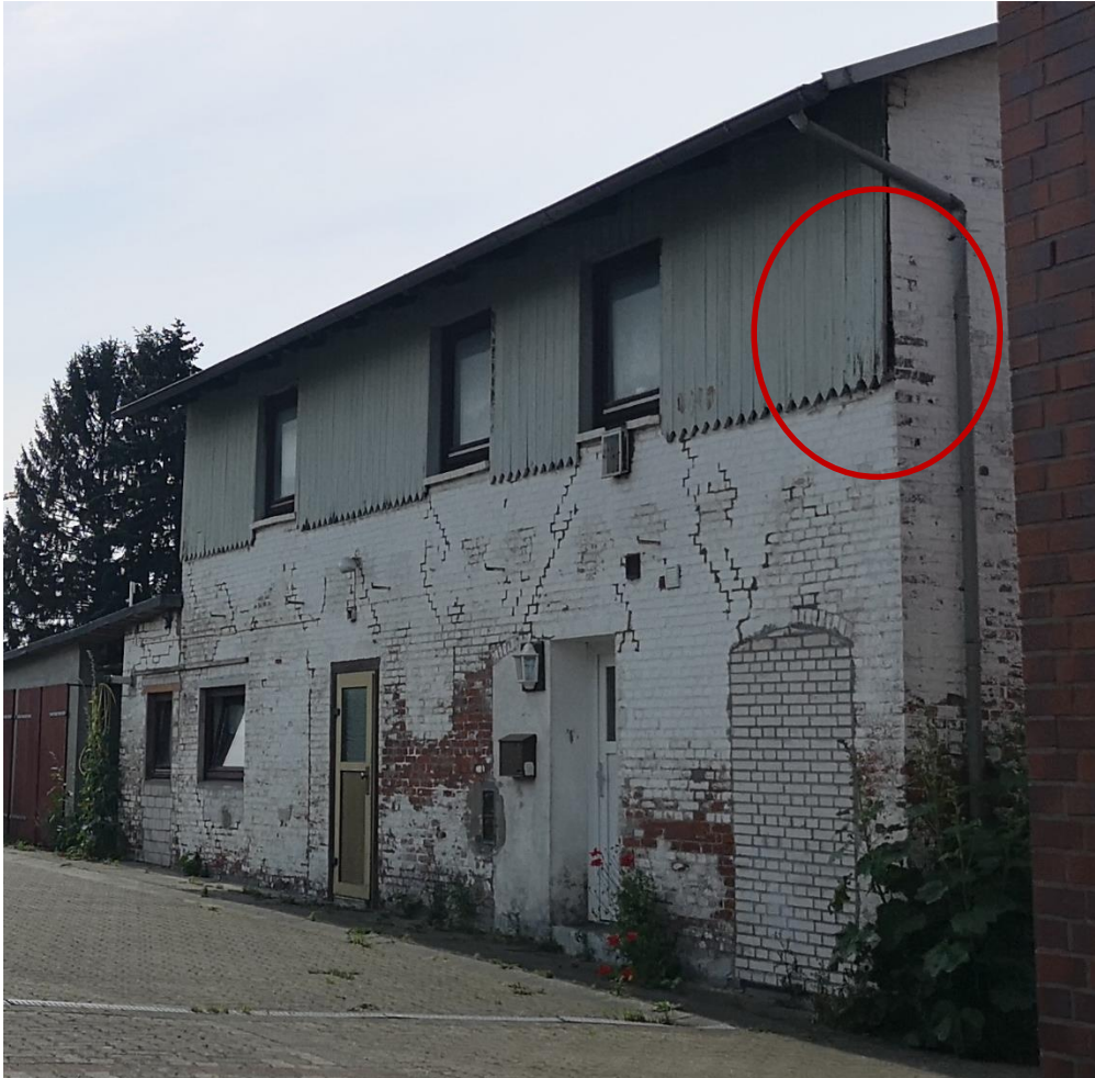
Abbildung 4: Altes Gebäude an der Mühlenstraße (Seitenansicht) mit Offenstelle hinter der Verkleidung als potenzielles Fledermaushabitat (rot umrandet)
